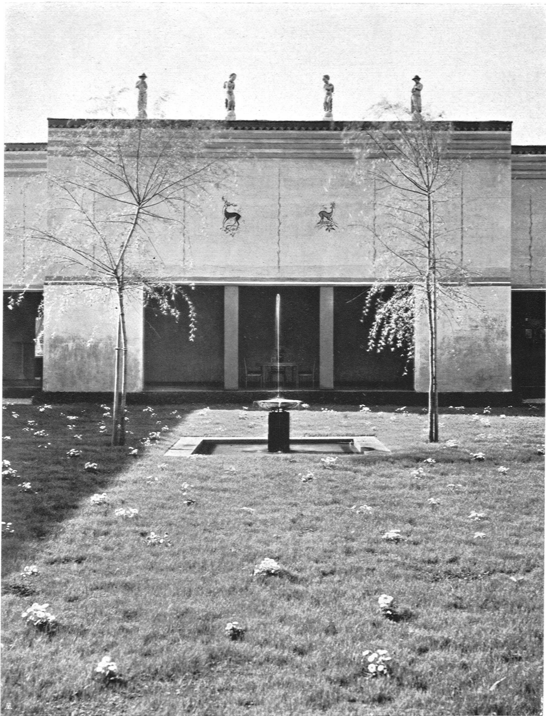
Vorbau am Marionettentheater. Brunnen und Brunnenschale, Entwurf: Architekt A. Altherr S. W. B., Ausführung in Messing: J. Vermeulen S. W. B., Zürich. Dekorative Malereien: W. Hartung S. W. B., Zürich Plastiken: E. Dallmann, Bildhauer S. W. B., Zürich
