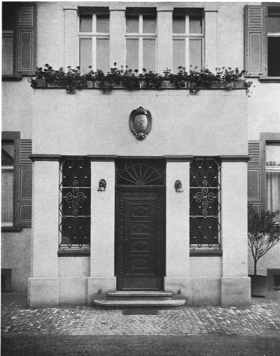
Eingang zum Bürobau einer chemischen Fabrik. Entwurf: Emil Bercher, Architekt S. W. B., Basel.
