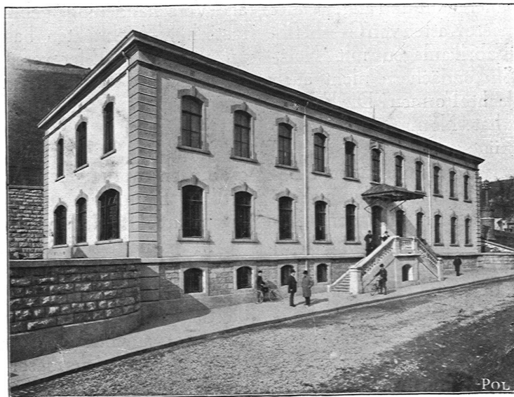
Verwaltungs- gebäude der A.-G. der Eisen- und Stahlwerke vor- mals G. Fischer, Schaffhausen.
