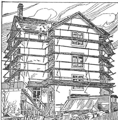
Ganz eingerüstetes Haus
