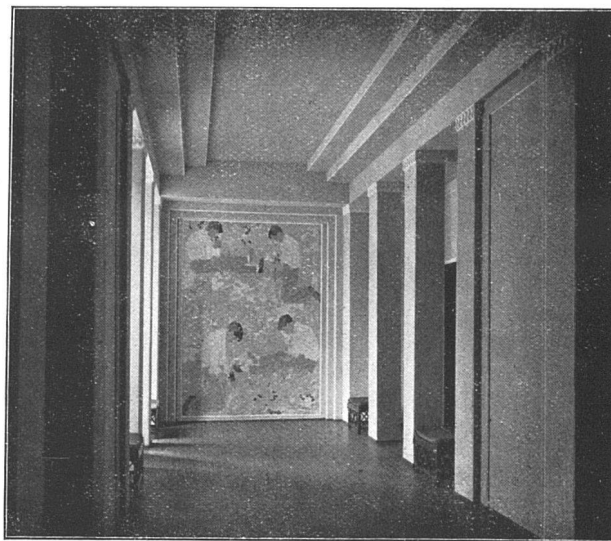
VORHALLE IN ETERNIT
