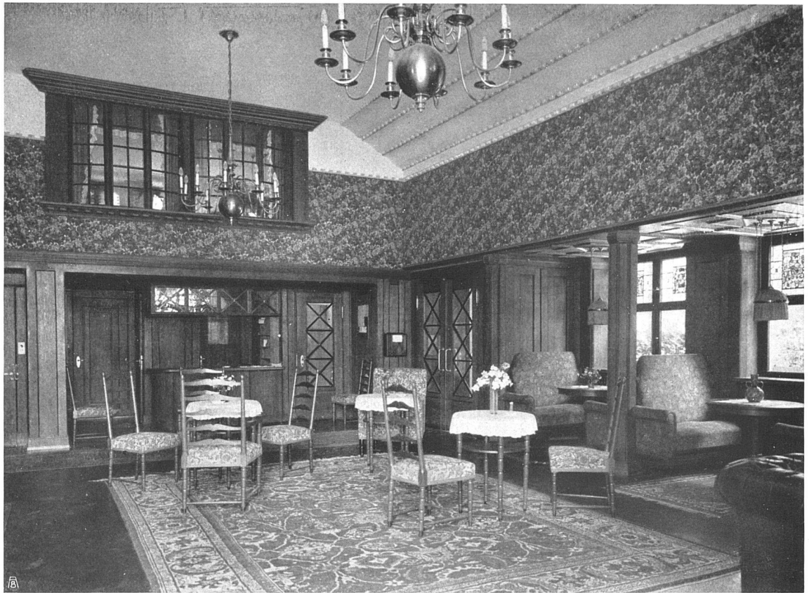
Parkhotel in Weggis, Halle
