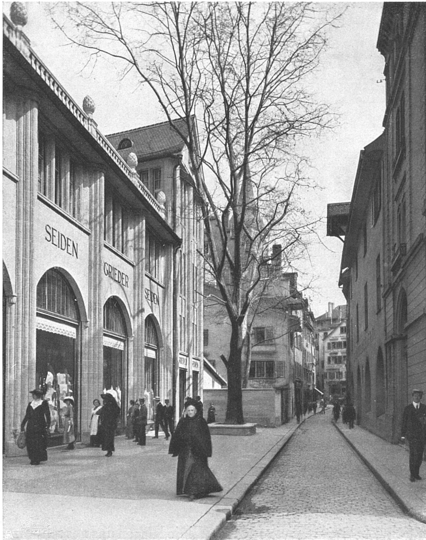
Peterhof in Zürich Fassadenteil Ingassen.
