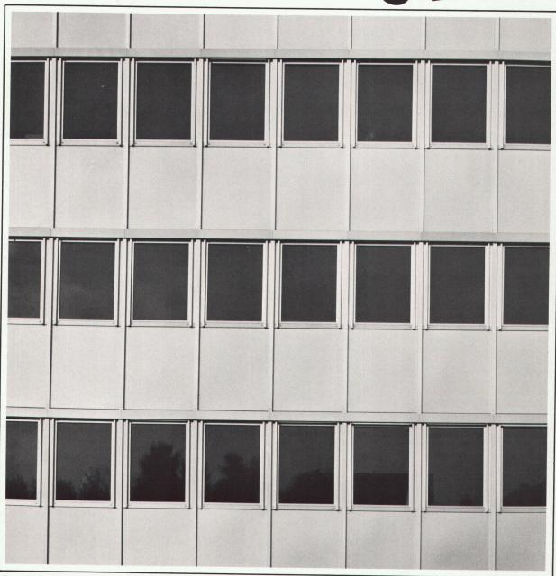
Verwaltungsbauten Vollisolierte Aluminiumfassade Leichtmetallfenster, Glissa Serie K Kittlose Isolierverglasung
