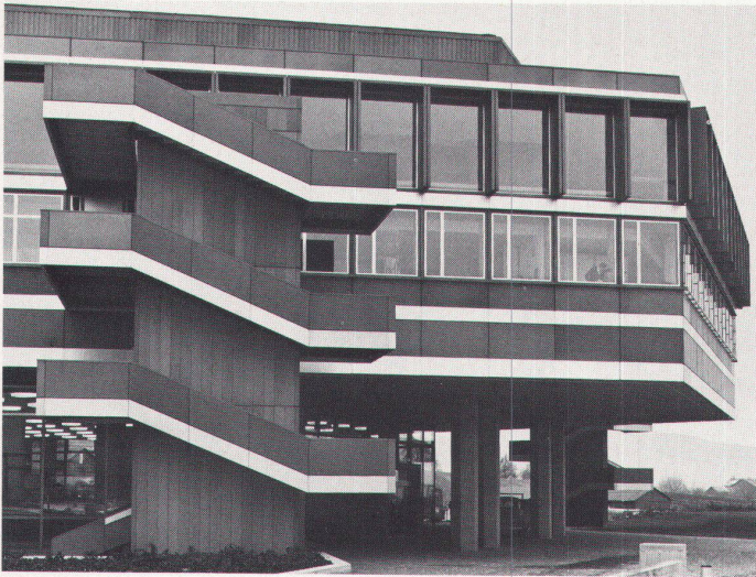
Grosses Hörsaalgebäude, Leichtmetallfassade und Fluchttreppe
