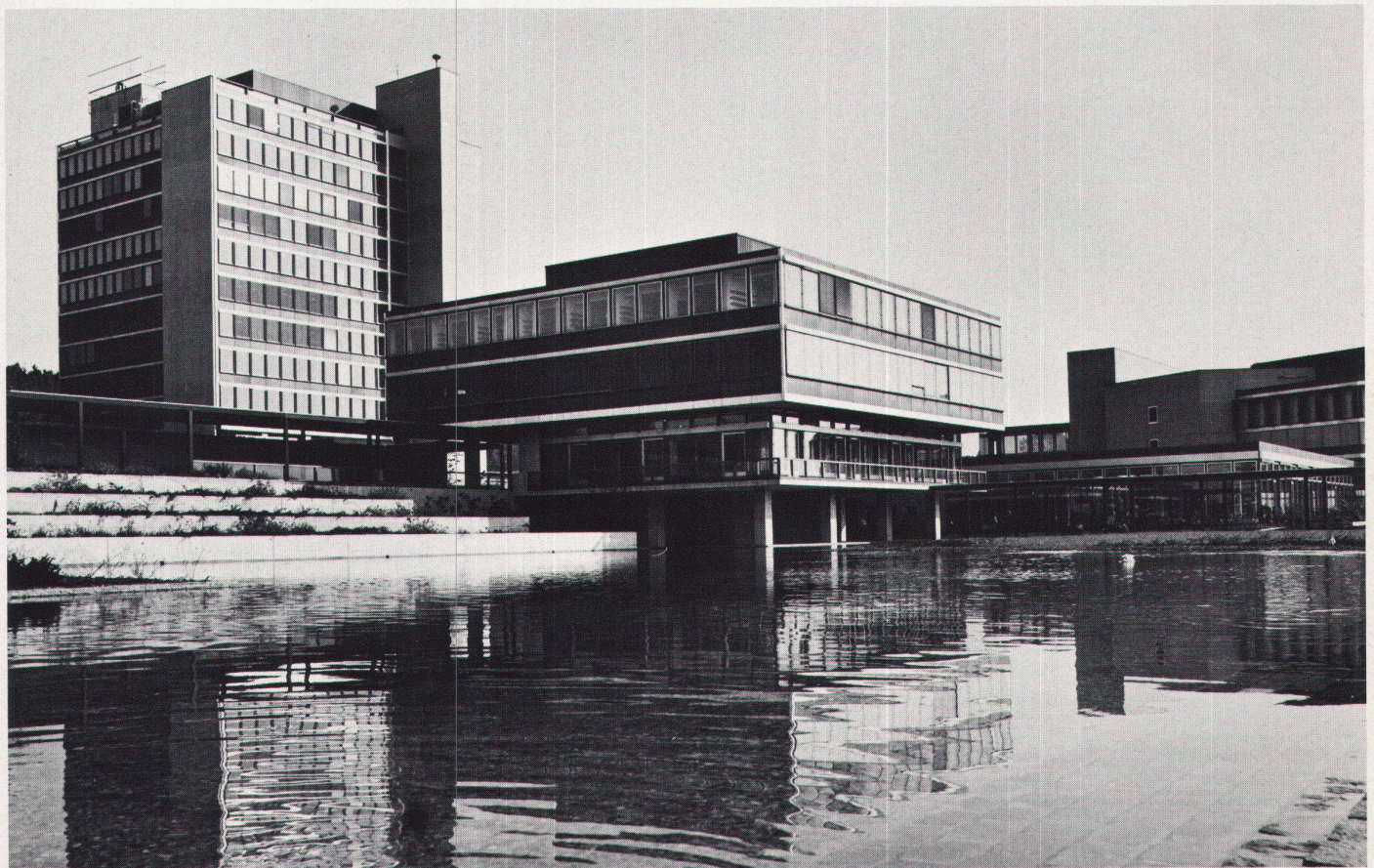
Blick vom Innenhof zum Praktikumbäude, Zentralgebäude, Studentenrestaurant und Hörsaaltrakt
