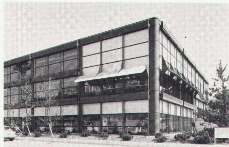
Eckpartie des Bürohauses der Helfer Architekten AG
