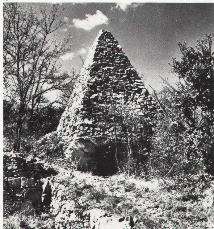
12 Kragsteinbau in der Provence. Innenschale bienenkorbförmig, Aussenschale als Spitzpyramide
