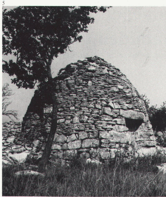
5 Kragsteinbau in der Provence, Luberon-Gebiet
