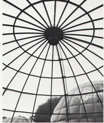
Auf dem Höhepunkt der Kuppel ist der Ventilator in die Tragkonstruktion eingebaut
