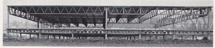
Aufbau der Strukturteile zum Hallenbau
