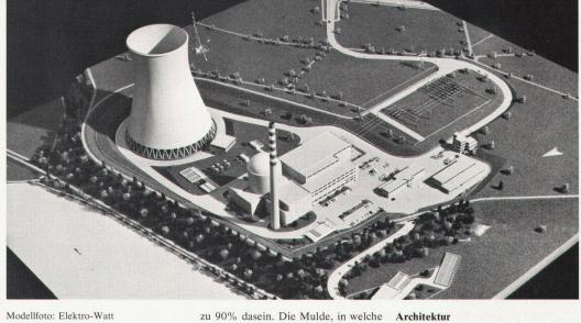
steht es überhöht auf einer breiten Kiesbank zwischen Bahnlinie und Strasse. Um diese Höhenlage zu vermeiden und die beträchtlichen Baumassen dem Gelände nicht auf-, sondern einzupflanzen, wurden sie in eine grosse künstliche Mulde abgesenkt. Dazu wurde ca. 1 Mio m³ Kies abgetragen, welcher u.a. dem Nationalstrassenbau zugeführt werden kann.
