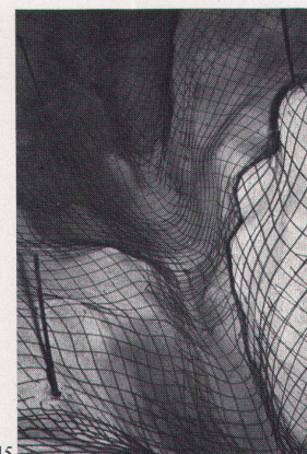
45 Netzarmerung auf erster Gunitsschicht
