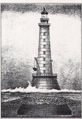
Leuchtturmmontage aus Stahl, deren Gewicht die Stabilität noch erhöhte.
