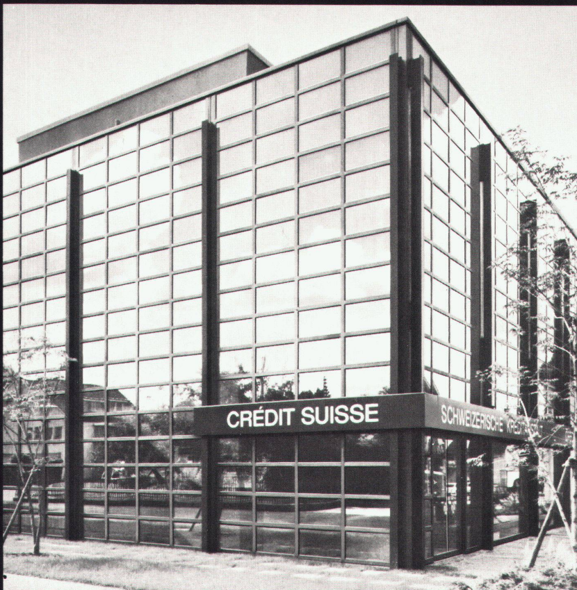
Bankgebäude der Schweizerischen Kreditanstalt in Wetzikon/ZH. Aluminium-Fassade mit vollisolierten Fenstern, Modell Alsec-50.
