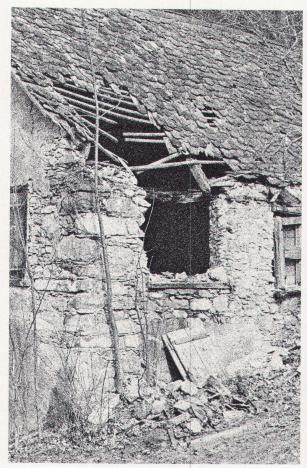
aber er zeigt deutlich die Folgen eines undichten Daches. Dachstuhl, Fassade und Innenräume werden durch ungehemmtes Einwirken der Witterung stark in Mitleidenschaft gezogen. Diese alte Mühle wurde Ende der fünfziger Jahre restauriert. Seither dient sie als Jugendherberge.
