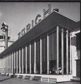
Seit 1951 für den Flughafen Kloten, projektiert, konstruiert, fabriziert, montiert. Aluminium-Fenster-und Fassadenkonstruktionen, Aluminium-Fenster-wände- und Grossverglasungen, Türenund Eingangspartien, Staubdecken und Vordächer, Metall-arbeiten am Kontrollturm, Aluminium-Pfeilerverkleidungen, diverse Aluminium-Spezialkonstruktionen. Brandschutz-Türabschlüsse, Elektranten-Deckel.
