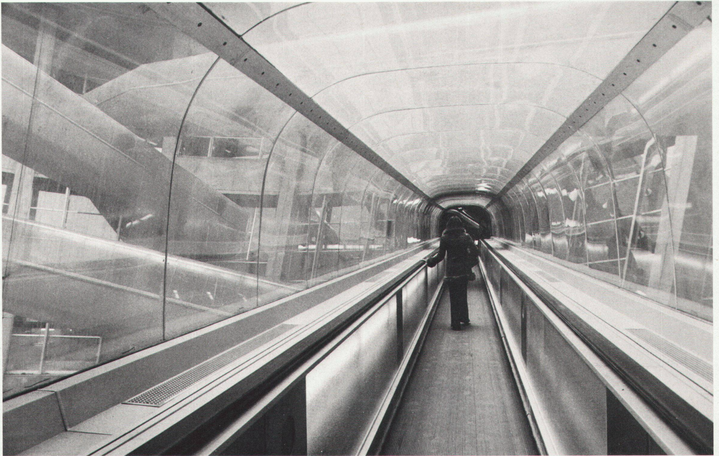
Un des tapis roulants au centre du bâtiment | Eines der Laufbänder im Inneren des Hauptgebäudes
