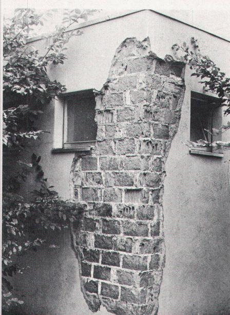
10, 11 Les limites de la technique et les méfaits du gel: bâtiment dans la région de Bienne présentant un décollement du crépiissage dû au gel qui a fait sauter les briques. (Deux documents communiqués par le Laboratoire d'essai des matériaux pierreux de l'EPFL.)
