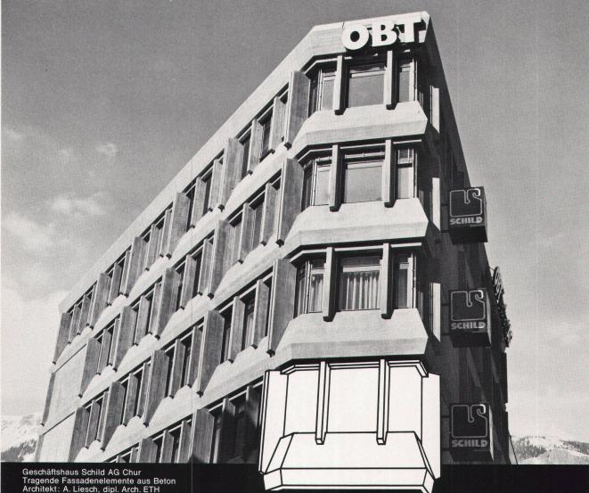
Tragende Fassadenelemente aus Beton Architekt: A. Liesch, dipl. Arch. ETH Ingenieur: G. Liesch, dipl. Ing. ETH Baugeschäft: Hch. Mettler + Söhne
