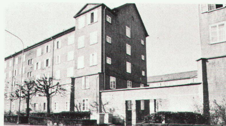
Teilansicht von der Seebahnstrasse aus
