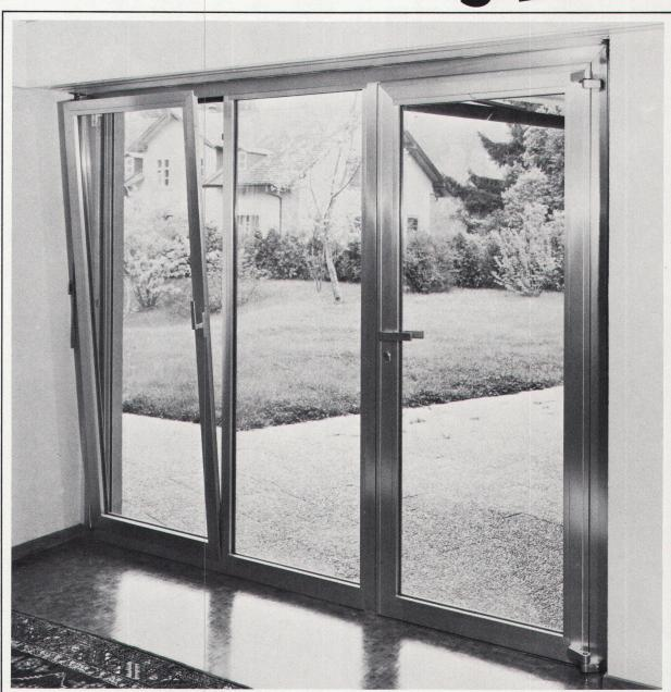
Wohnhausbau Balkontüre mit Drehkippflügel Ganzaluminiumkonstruktion, Glissa Serie K Kittlose Isolierverglasung
