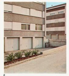
9 Anliker + Co AG, Emmenbrücke Kipptore, halbverschwindend, mit Seilzug. Hubtore mit Gegengewichten und Seilzug Portes basculantes à câbles, partiellement escamotables. Portes coulissantes verticales à câbles et contre-poids
