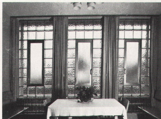
Glasbausteinfenster mit Anticorodal-Drehflügel in Sitzszimmer.
