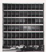
Fassadenelemente. Durch sinnvolle Kombinationen aller Fensterarten mit vorfabrizierten Brüstungen und Stützen entstehen Fassadenelemente modernster Kon-
