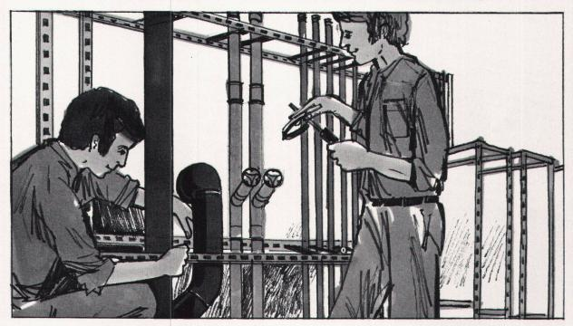
Das einfache Baukastensystem ermöglicht es dem Installateur, die MONTEL-Blöcke in der Werkstatt zu montieren. Das bedeutet Verkürzung der Montagezeit und geringere Umtriebe auf der Baustelle. Das vielseitige +GF+ Montage-System MONTEL setzt sich aus vier Grundelementen zusammen:
