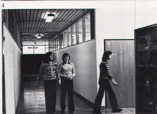
3-6. Ziel des Innenausbaus war es, mit Verwendung von Bauteilen aus Holz eine wohliche Atmosphäre zu schaffen. In den Innenräumen wurde versucht, durch den Einbau von Glasflächen im oberen Bereich der Trennwände und die Aufteilung von Nutzungsbereichen mittels frei stehender Schrankelemente eine Transparenz in der Struktur zu erzielen.
