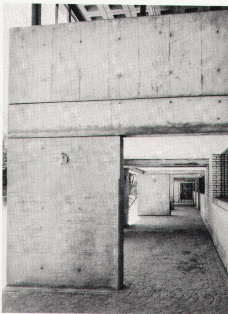
Portiques longitudinal et transversal avec accès à l'unité didactique
