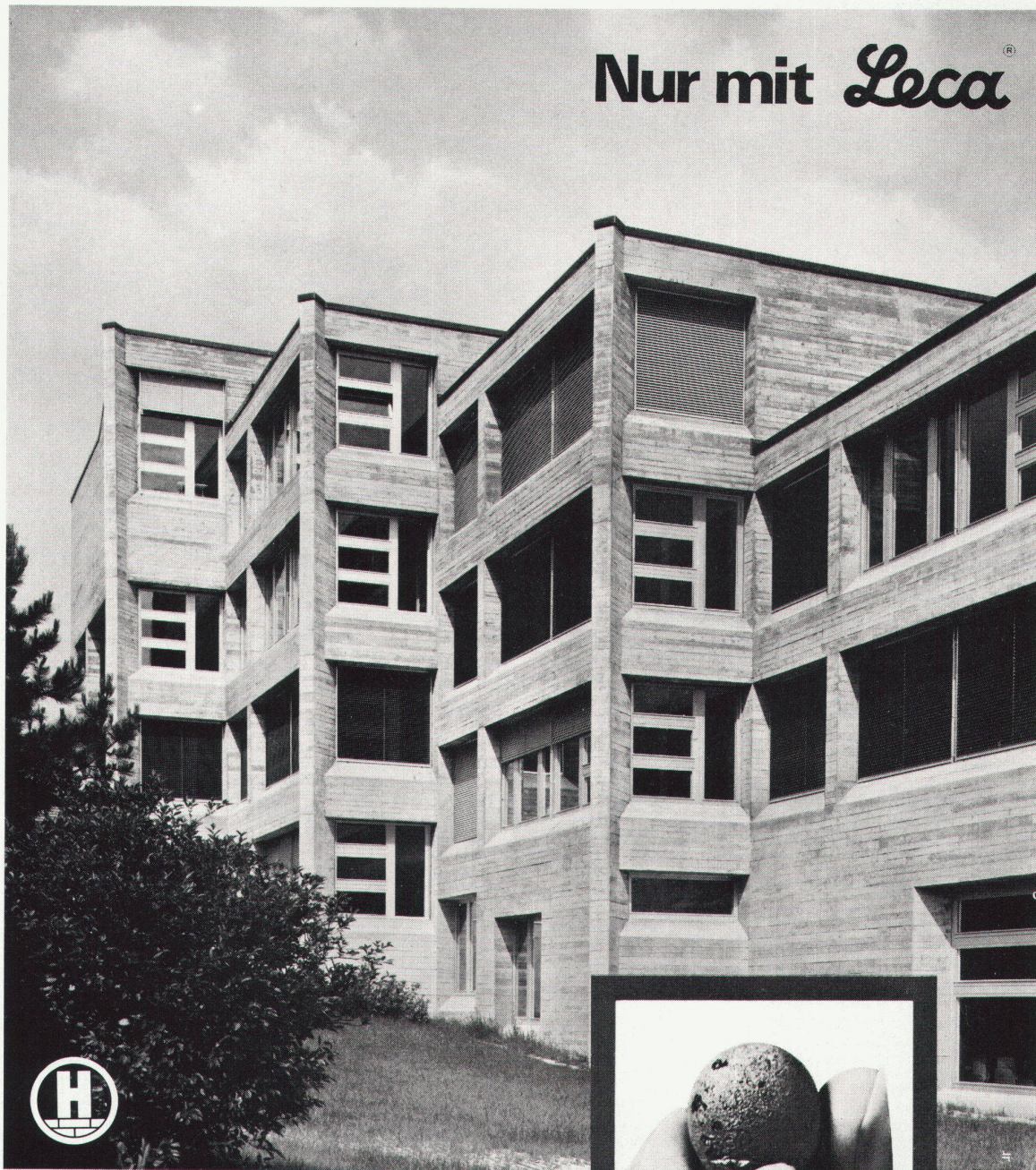
Klassenzimmer-Trakt des Oberstufen-Schulhauses in Dielsdorf aus Leca -Sichtbeton
