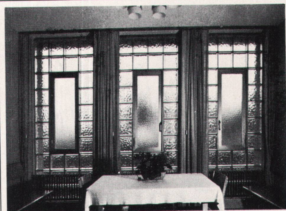
Glasbausteinfenster mit Anticorodal-Drehflügel in Sitzungszimmer.
