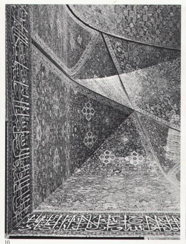
10 L'analyse des voûtements par des prises de vue zénithales: cette image représente la moitié gauche de l'iwan ouest de la Mosquée du Shah. Ici, le tracé est fondé sur un octogone, obtenu par la rotation de 45° d'un carré par rapport à un autre. La trompe est alors symétrique. (Hasselblad, 50 mm.)
