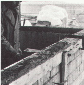
9 Zementmörtel einfüllen Remplir de mortier
