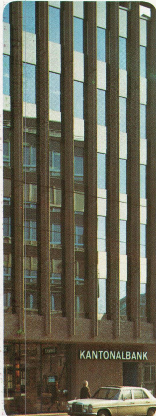
Kantonbank und Schweizer Bankverein Basel – Schweiz, 1972 INFRASTOP-Auresin 39/28 kombiniert mit PHONSTOP Burckhardt + Partner Architekten, Basel
