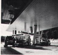
Autobahn-Tankstelle Würenlos LUXALON®-Fassadenverkleidung Typ 150 F (als Decke montiert)
