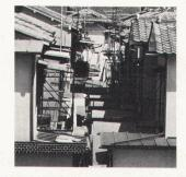
Des cours intérieures sont couvertes pour l'installation de nouveaux blocs sanitaires préfabriqués.
