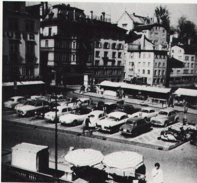
Rathausbrücke vorher (Foto: BAZ)
