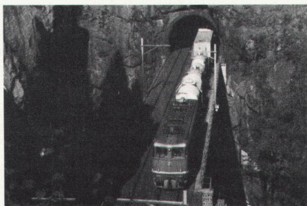
Rampe nord du Saint-Gothard, tunnel hélicoïdal de Leggistein. Photo: CFF
