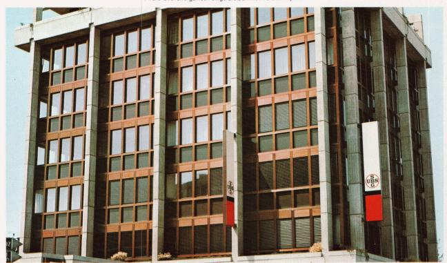
ist ein elektrolytisches Einfärben für anodisch erzeugte Oxidschichten auf Aluminium und seinen Legierungen. Daraus resultieren dekorative, wirkungsvolle, dauerhafte und absolut lichtechte Farbtöne, welche im Farbbereich Hellbronze-Braun-Schwarz zusammengefasst sind. Anodisiertes Aluminium mit seinen vorzüglichen Eigenschaften, verbunden mit den farbigen Oxidschichten, bietet sich dabei hervorragend für die praktische Verwendung in der Aussenarchitektur an.
