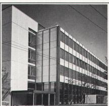
Die Firma Geilinger (Geilinger & Co., Metallbau, Winterhur) lieferte Brüstungsverkleidungen (750m²), Stützenverkleidungen (380 Stück) sowie Leichtmetall-und Holz/Metall-Fenster (2400m²).
