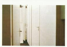
Die WC-Wände sind aus Spanholz-Vollmaterial, Bauhöhe 200 cm, inkl. 10 cm Bodenfreiheit. Anforderungen genügt, ca. 30 db schalldämmend. Typ S-100:100 mm stark als vollmobile Bürotrennwand, die erhöhte Anforderungen erfüllt, ca. 40 db schalldämmend. Typ I-60: 60 mm stark als Industrietrennwand in besonders robuster Ausführung.
