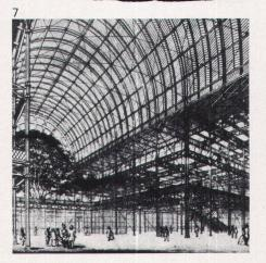
Joseph Paxton, Wand des Längsschiffes des Kristallpalastes, London 1851. Aufhebung der Trennung von Aussen- und Innenraum. Das Prinzip der Vorfabrikation führt zu einer additiven und regelmässigen Abständigkeit des technisch-architektonischen Aufbaus.
