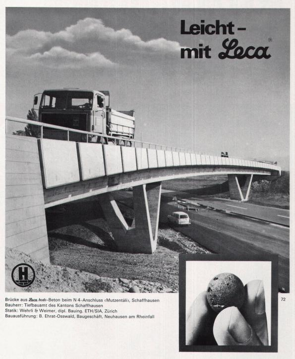
Weitgespannte Brücken sind im Autobahnnetz keine Seltenheit mehr. Und doch ist jede Brücke eine individuelle Leistung des Projektierenden und des Ausführenden. So auch in Schaffhausen: Auf schwierigem Baugrund und innerhalb sehr knapper Nutzhöhen muss eine Hauptstrasse die N 4 in spitzem Winkel überqueren. Eine dreifeldrige, teilweise vorgespannte Rahmenkonstruktion mit Hohlkastenquerschnitt und V-Stützen stellt die Lösung dar. Sie ist technisch bemerkenswert und schön.
