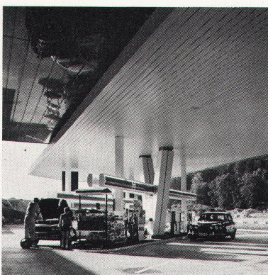
Autobahnrestaurant Würenlos LUXALON®-Fassadenverkleidung Typ 150 F (als Decke montiert)
