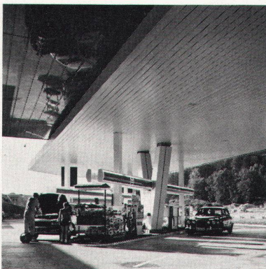
Autobahnrestaurant Würtenlos LUXALON®-Fassadenverkleidung Typ 150 F (als Decke montiert)
