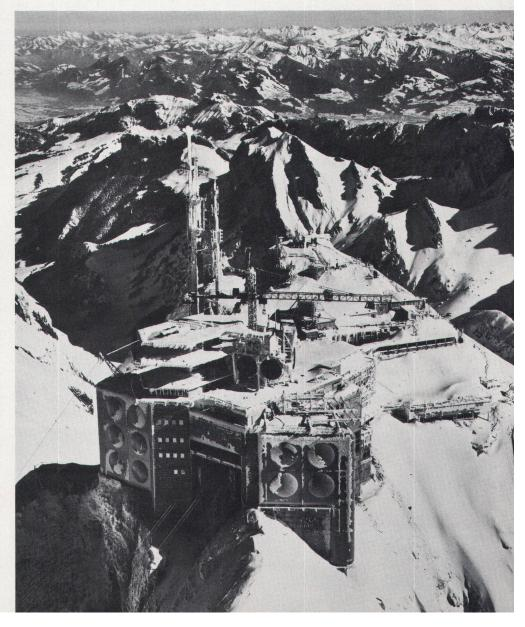
Nicht überall lassen sich Technik und Landschaftsschutz so glücklich verheiraten wie auf dem Säntis. So musste, bedingt durch bestehende Bauservitute, bei der Erstellung der Sendeanlage Rigi (2) eine für die Technik recht unvorteilhafte und teure Lösung gewählt werden. Die örtliche Trennung von Gebäude, Sendeturm und Richtstrahlkaverne verursacht lange Energieleiter zwischen Sender und Antennen, was zu grossen Leistungsabfällen und damit zu einer schlechten Ausnützung der Sendeanlagen führt.
