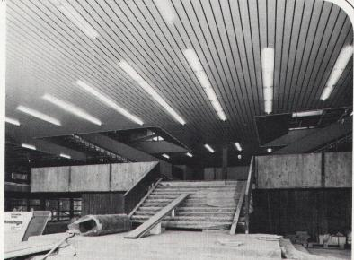
Besser gesagt, weil LUXALON®-Aluminiumdecken die bessere Lösung sind. Als dekorative Akustik- und Lüftungsdecken. Weil sie hohe tive Akustik- und Lüftungsdecken. Weil sie hohe Korrosionsfestigkeit bieten, weil sie schnell montiert werden können, weil sie ideale Gestaltungsmöglichkeiten bieten, weil Leitungen und Installationen immer zugänglich bleiben.
