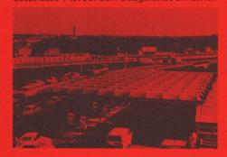
Essen und Mülheim eine Grosstankstelle errichtet worden. Die Dachkonstruktion der Tankstelle wurde als flexibles Flächentragwerk aus beschichteten Geweben ausgebildet.
