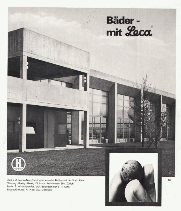
Bauphysikalisch sind Hallenbäder schwierige Objekte. Zwischen dem Innern und der Aussenluft bestehen – namentlich bei kühlerem Wetter, wenn das Hallenbad besonders geschätzt ist – grosse Unterschiede in der Temperatur und in der Luftfeuchtigkeit.
