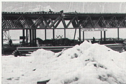
Satellitenstation Leuk: mit Holorib-DLW gebaut.
