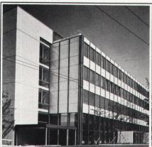
Die Firma Geilinger (Geilinger & Co., Metallbau, Winterhur) lieferte Brüstungsverkleidungen (750 m²), Stützenverkleidungen (380 Stück) sowie Leichtmetallund Hols/Metall-Fenster (2400 m²).
