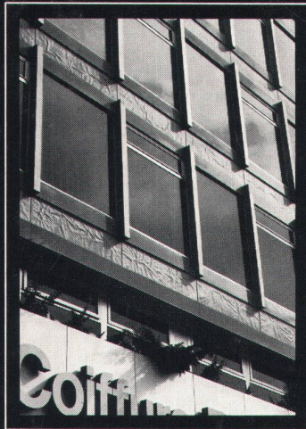
E. Hauer's Erben, Zürich Geschäftshaus mit vollisolierten ALSEC-50-Fenster, Isolierplatten-Brüstungen mit vor- gehängten Silafont-Gussplatten.
