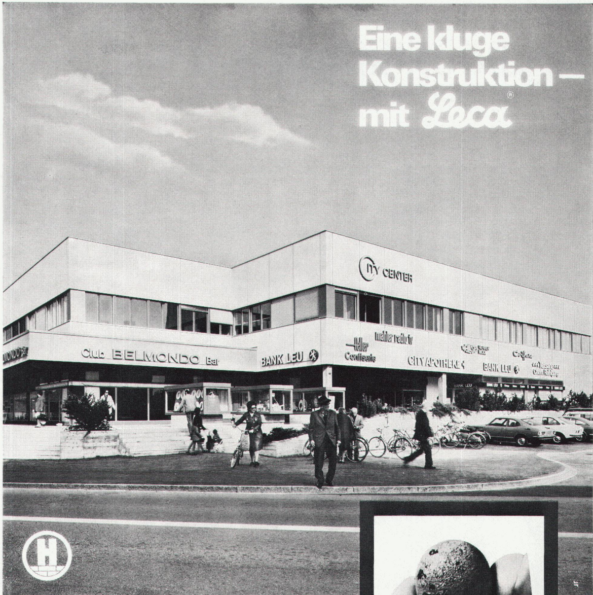
City-Center in Dübendorf mit Leca -Fassadenelementen Bauherr: Horta Generalunternehmung AG, Zürich Planung: R. Klemenz + R. Flubacher, Architekten, Zürich Statik: A. Böhli, dipl. Ing. SIA, Zürich Bauausführung: Umberto Bonomo Söhne AG, Bauunternehmung, Zürich
