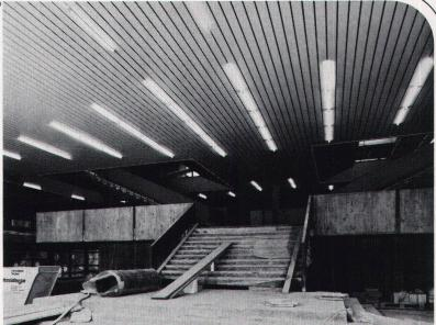
Besser gesagt, weil LUXALON®-Aluminiumdecken die bessere Lösung sind. Als dekorative Akustik- und Lüftungsdecken. Weil sie hohe Korrosionsfestigkeit bieten, weil sie schnell mon-tiert werden können, weil sie ideale Gestaltungs-möglichkeiten bieten, weil Leitungen und Installa-tionen immer zugänglich bleiben.
